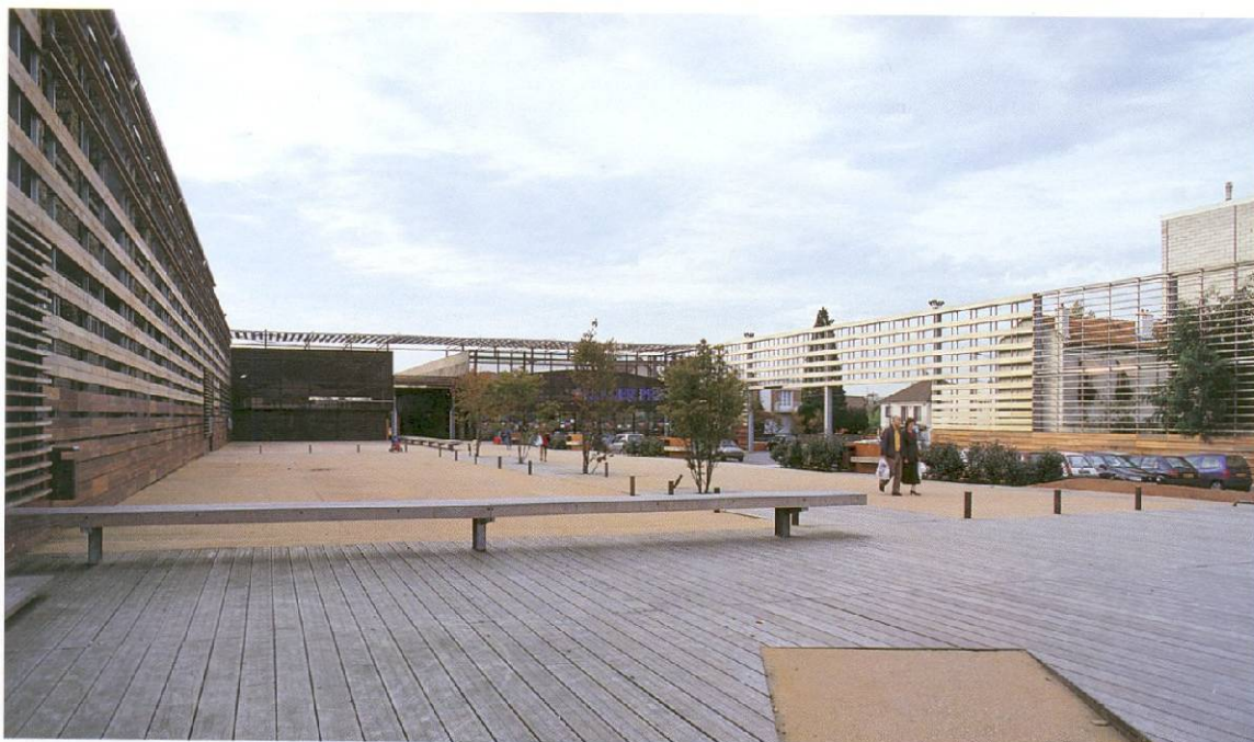
Marché des Gravilliers, 33, avenue François-Mitterrand, Athis-Mons.
